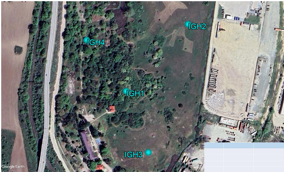
Figura 4-1.2.4. Amplasarea geografică a elementelor stației infrasonice AGIR
